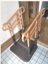
割り段手すり
